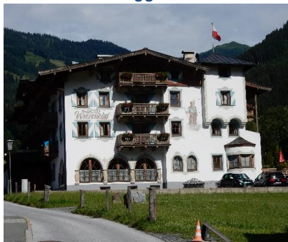
Parkplatz vor dem Hotel und rechts dahinter
